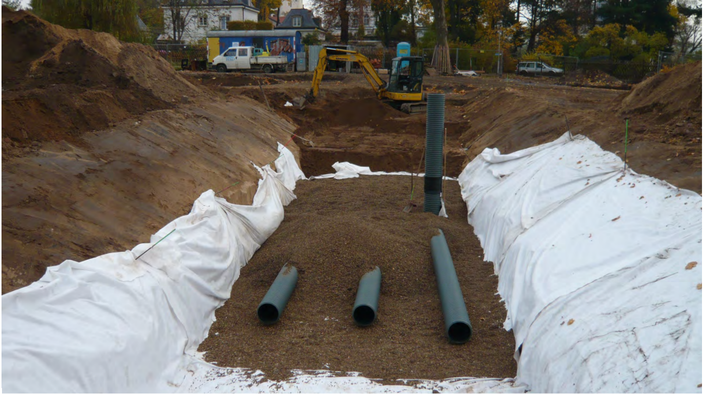
Kiesrigole, die um Überflutungsvolumen erweitert werden kann.
