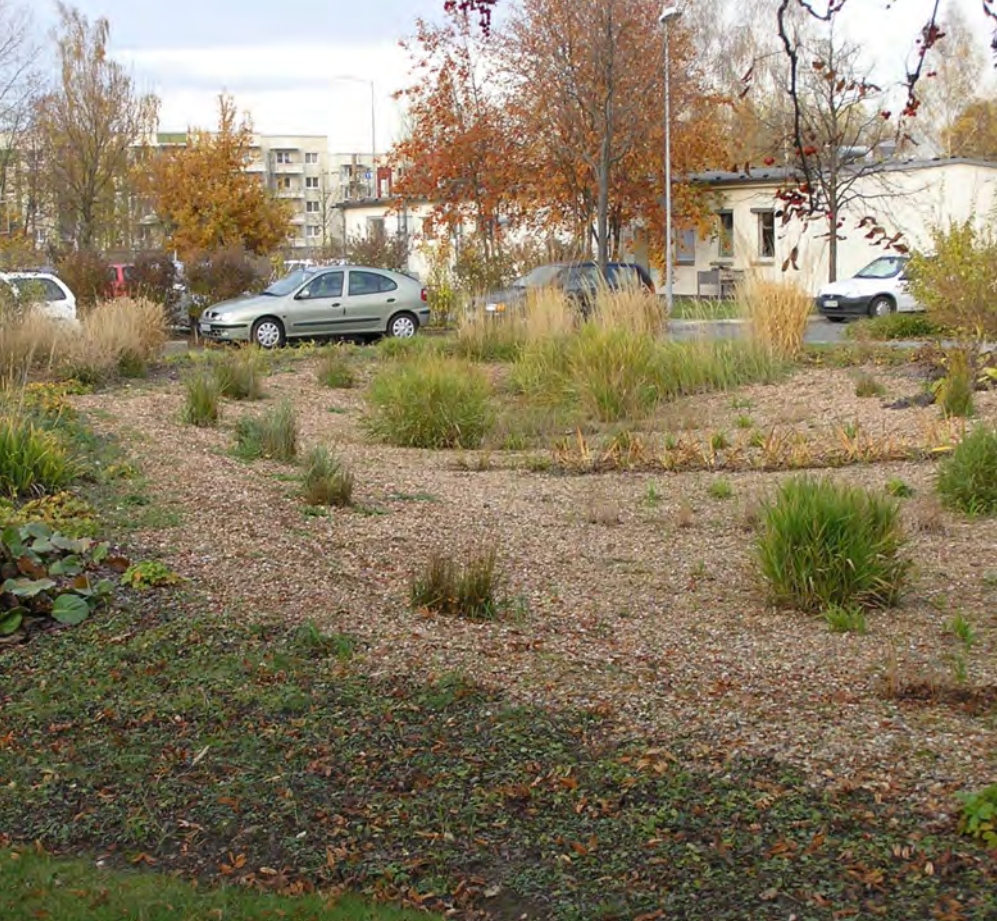
Bepflanzte Mulde nach Fertigstellung.
