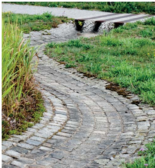
Rinne zur offenen Wasserführung
