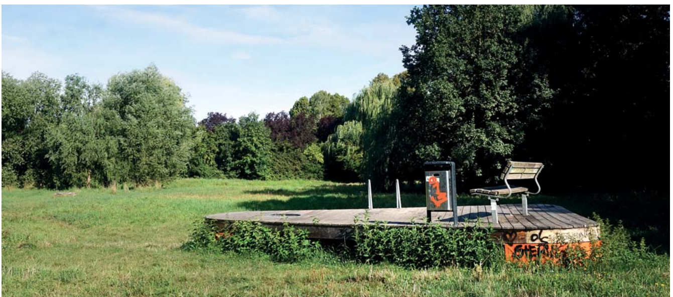
Diese Sitzinsel in einer Mulde wurde so konstruiert, dass sie bei Einstau aufschwimmt
