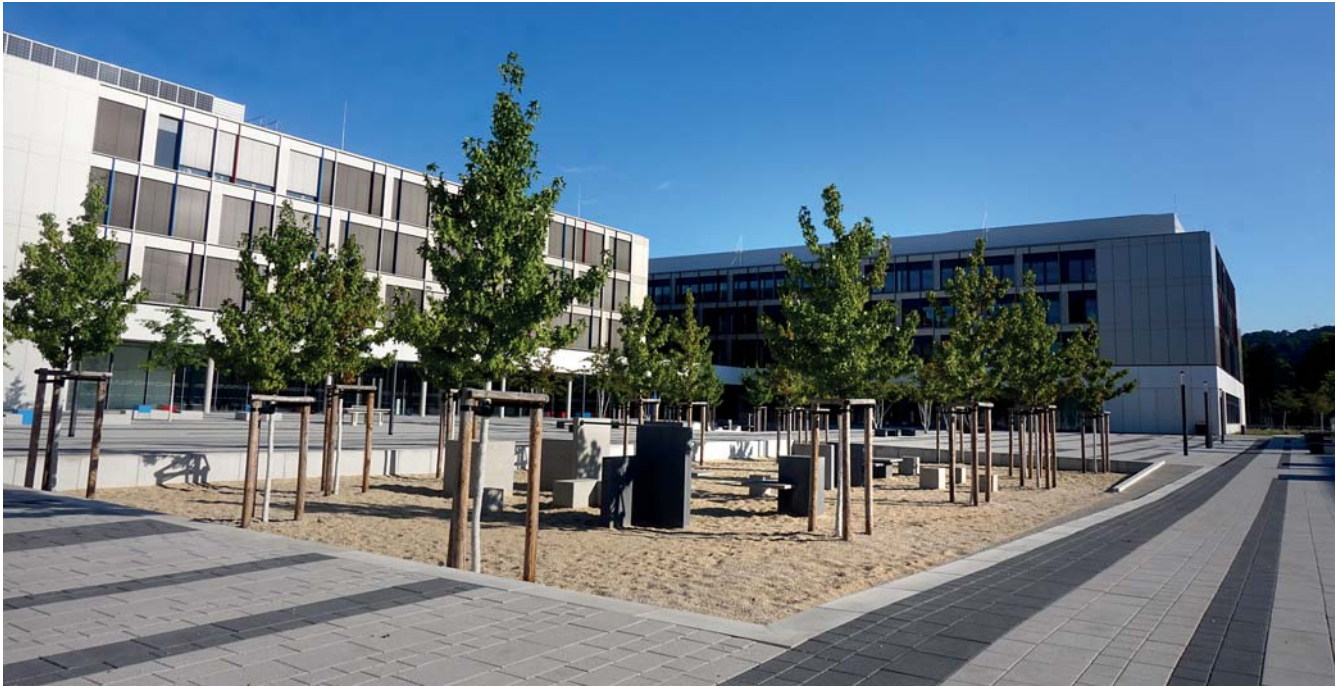
Abgesenkte Aufenthaltsfläche mit viel Raum für Überflutungsvolumen
