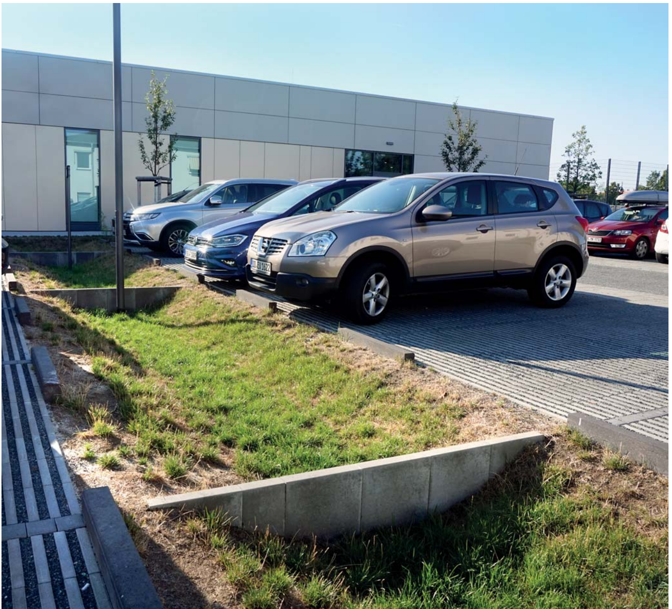
Abgetrepte Mulde mit Längsgefälle
